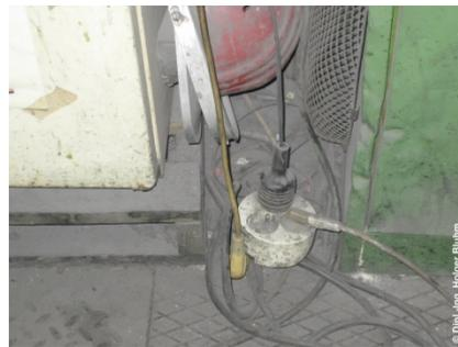
Abb.2: Unzulässige Verwendung einer ortsveränderlichen Mehrfachsteckdosenleiste in einem Industriebetrieb
