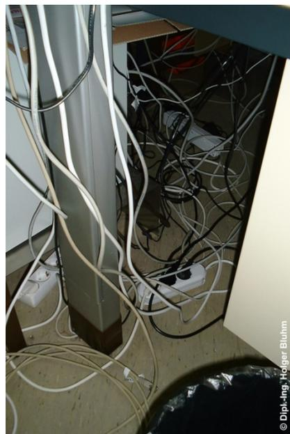
Abb.3: Gefährliche Erhöhung der Schleifenimpedanz durch unzulässiges Hintereinanderstecken von ortsveränderlichen Mehrfachsteckdosenleisten
